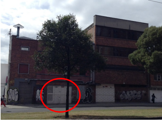
Foto No. 06 – Predio donde se almacenan los residuos peligrosos.
